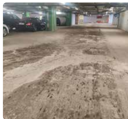
Проезд. Даже на прямом проезде — колея вдоль траектории колёс.
