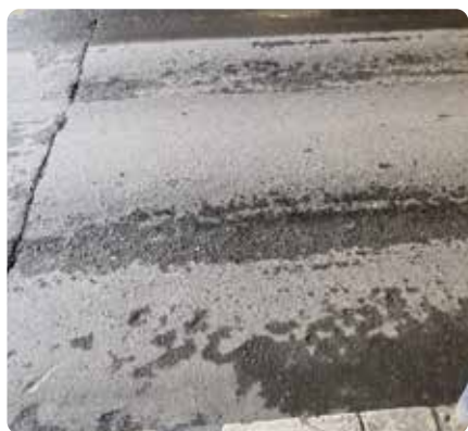
Подход к шлагбауму. Полосы износа ровно там, где машины тормозят и трогаются.
